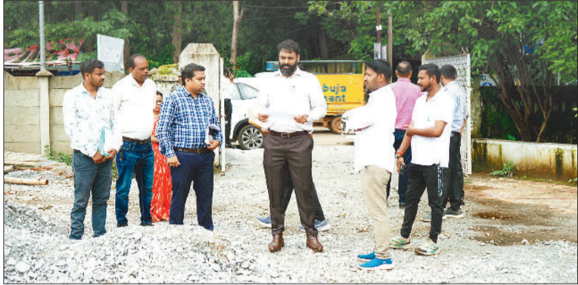
निर्माणाधीन अस्पताल परिसर का निरीक्षण करते कलेक्टर।
